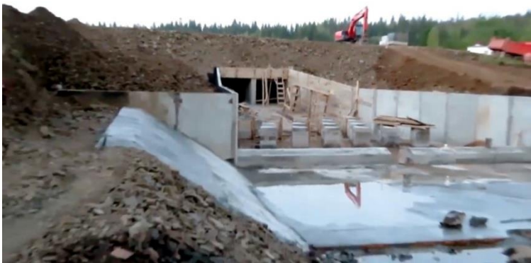
Фото 3. Строительство ГТС пруда в п. Кормовище, сливное устройство в нижнем бьефе
