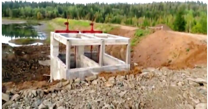
Фото 2. Строительство ГТС пруда в п. Кормовище, верхний бьеф*
